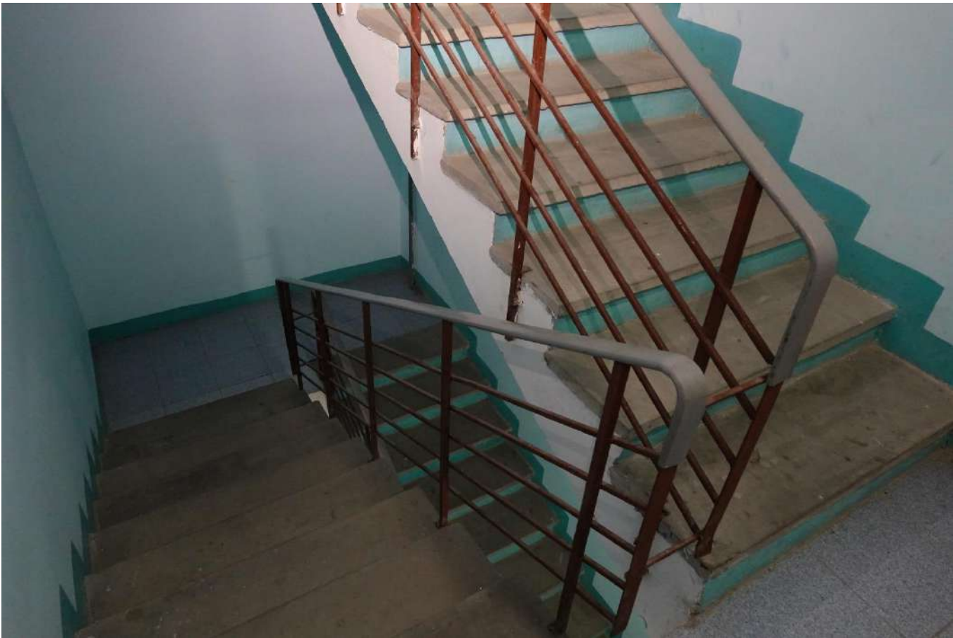
Фото 22. Общий вид лестничной клетки подъезда №1
