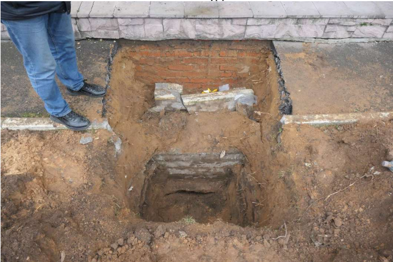
Фото 45. Вид фундамента в шурфе 1
