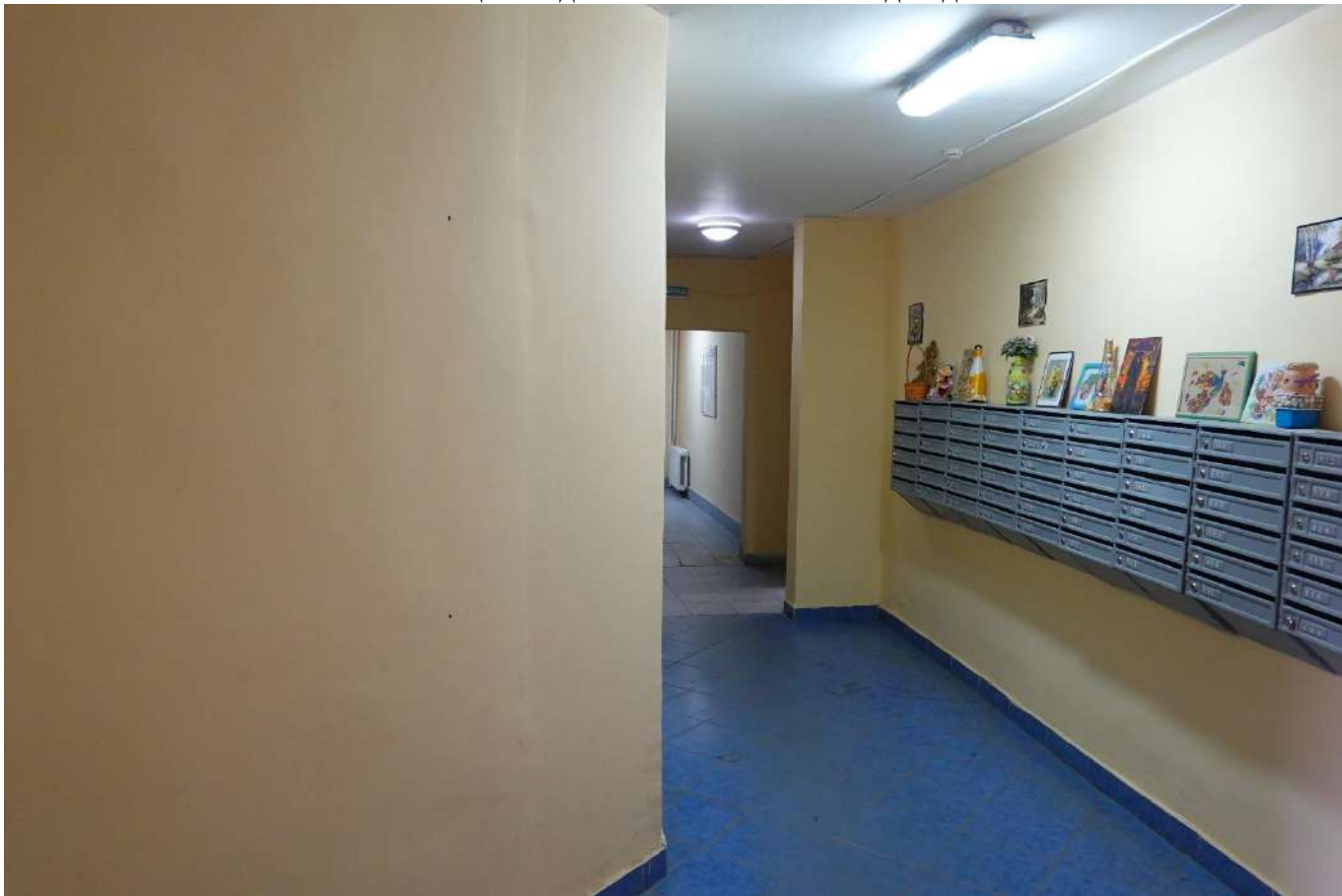
Фото 27. Общий вид холла МОП подъезда №3
