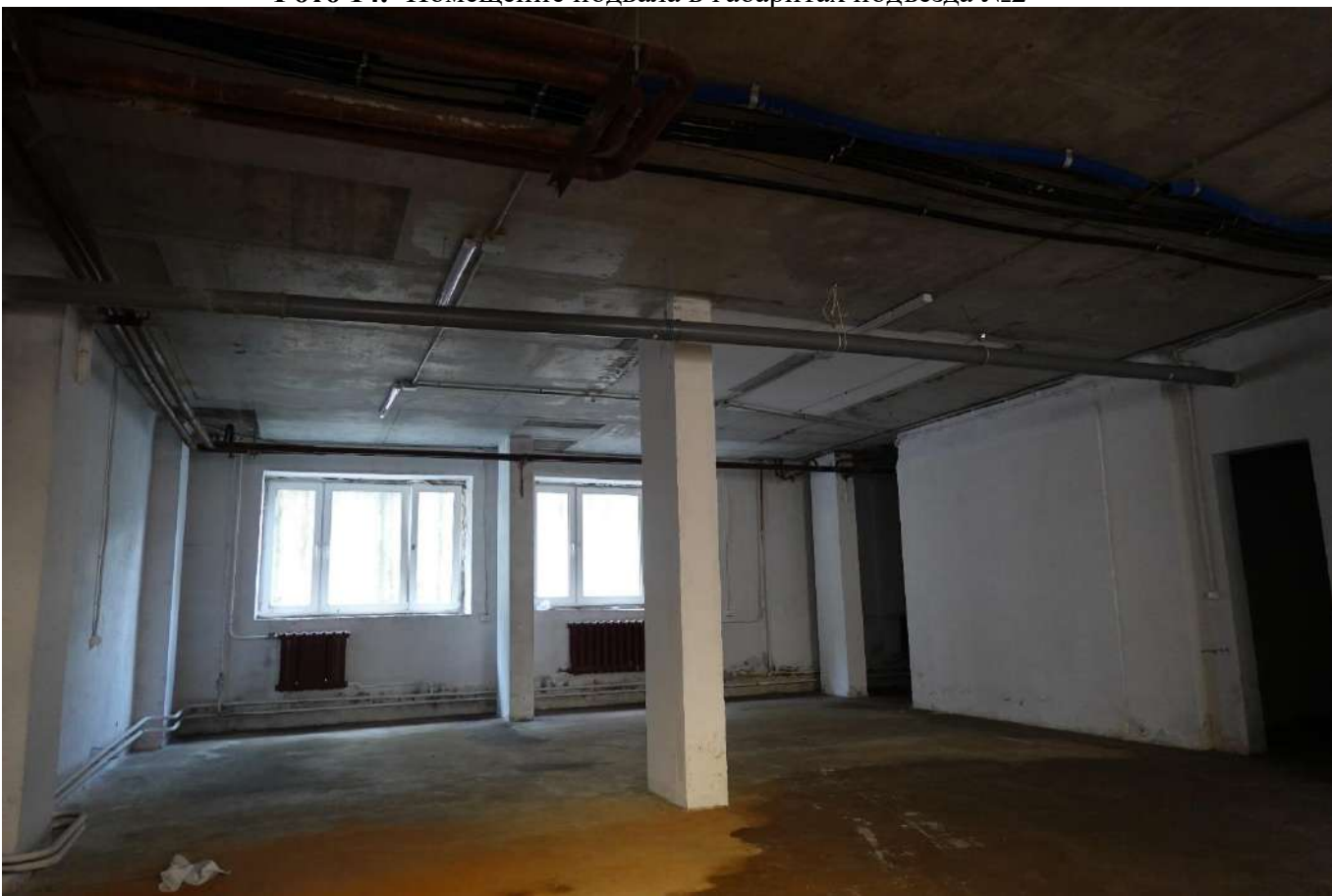
Фото 15. Помещение подвала в габаритах подъезда №2
