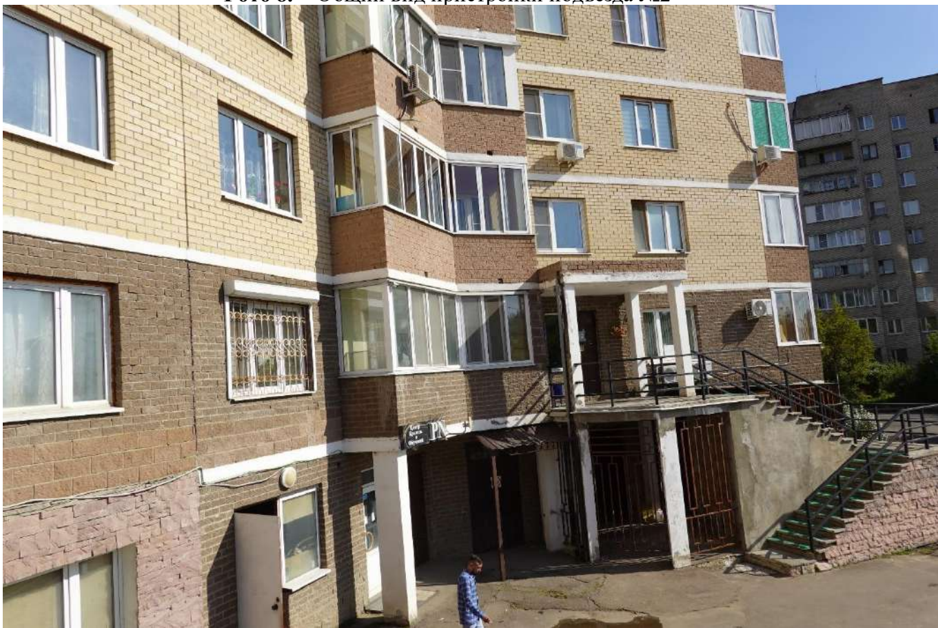
Фото 9. Общий вид входной группы подъезда №3
