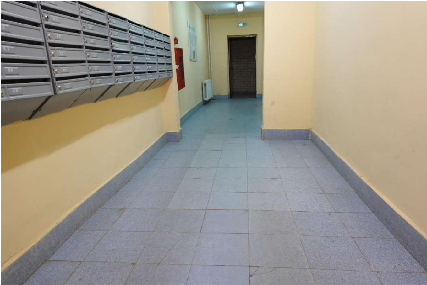
Фото 23. Общий вид холла МОП подъезда №2
