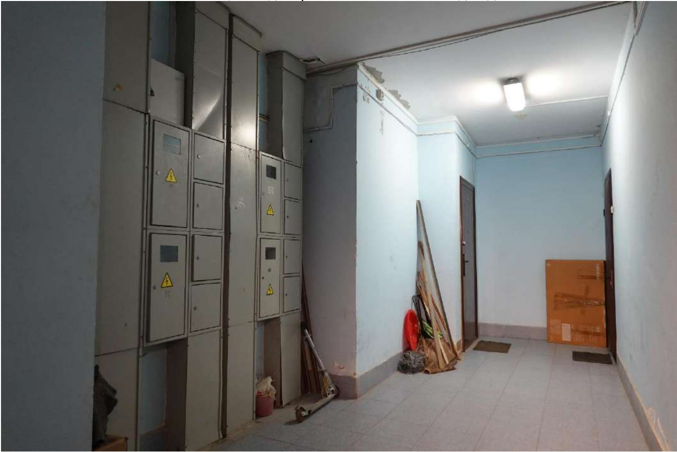
Фото 25. Общий вид приквартирного холла МОП подъезда №2
