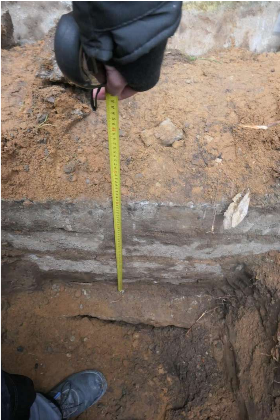
Фото 46. Замеры конструкции фундамента в шурфе 1
