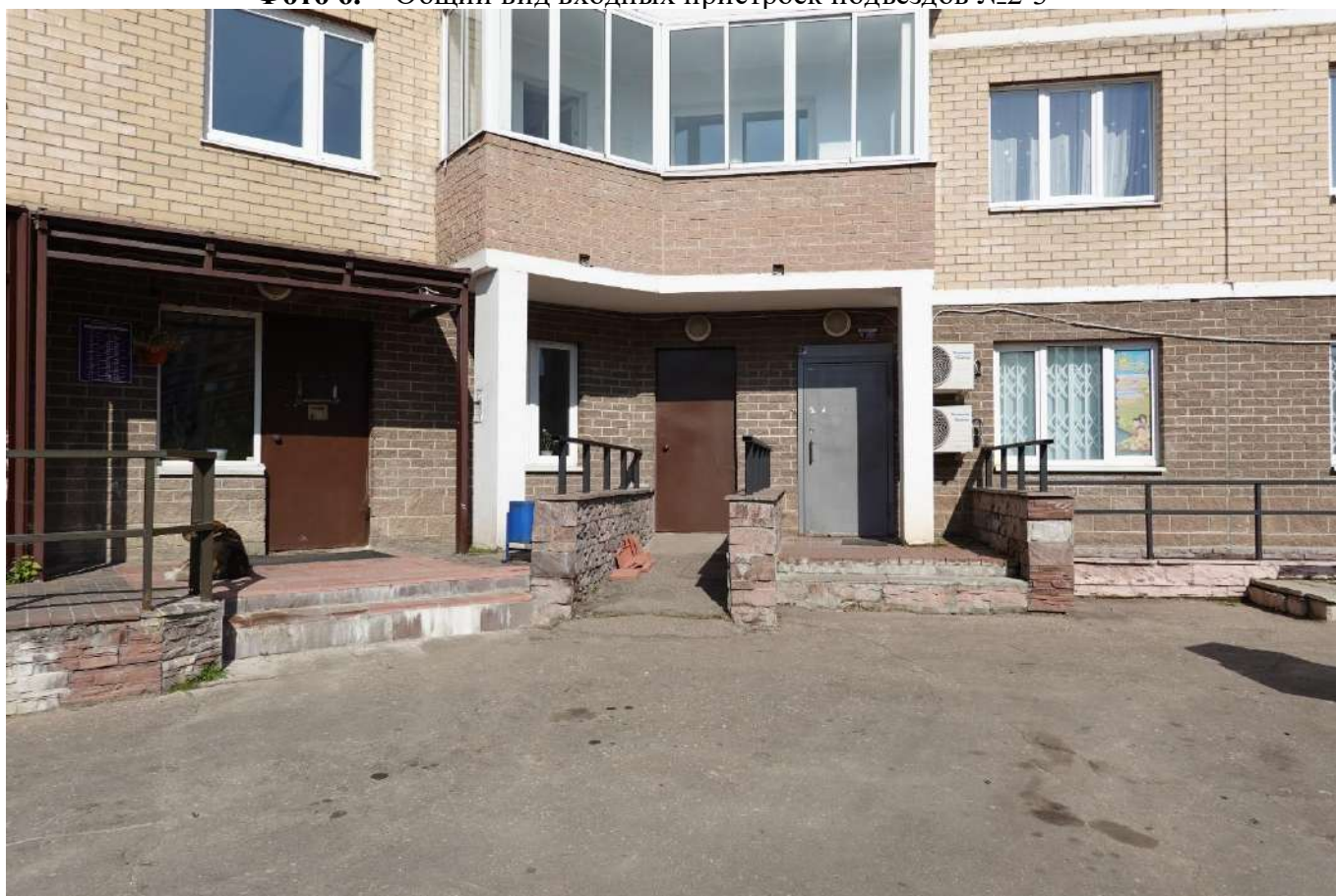
Фото 7. Общий вид входной группы подъезда №1
