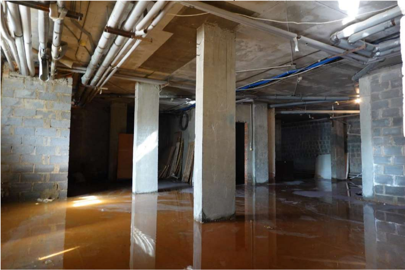
Фото 17. Помещение подвала в габаритах подъезда №2
