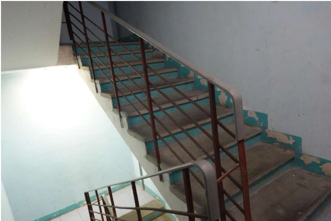
Фото 26. Общий вид лестничной клетки подъезда №2
