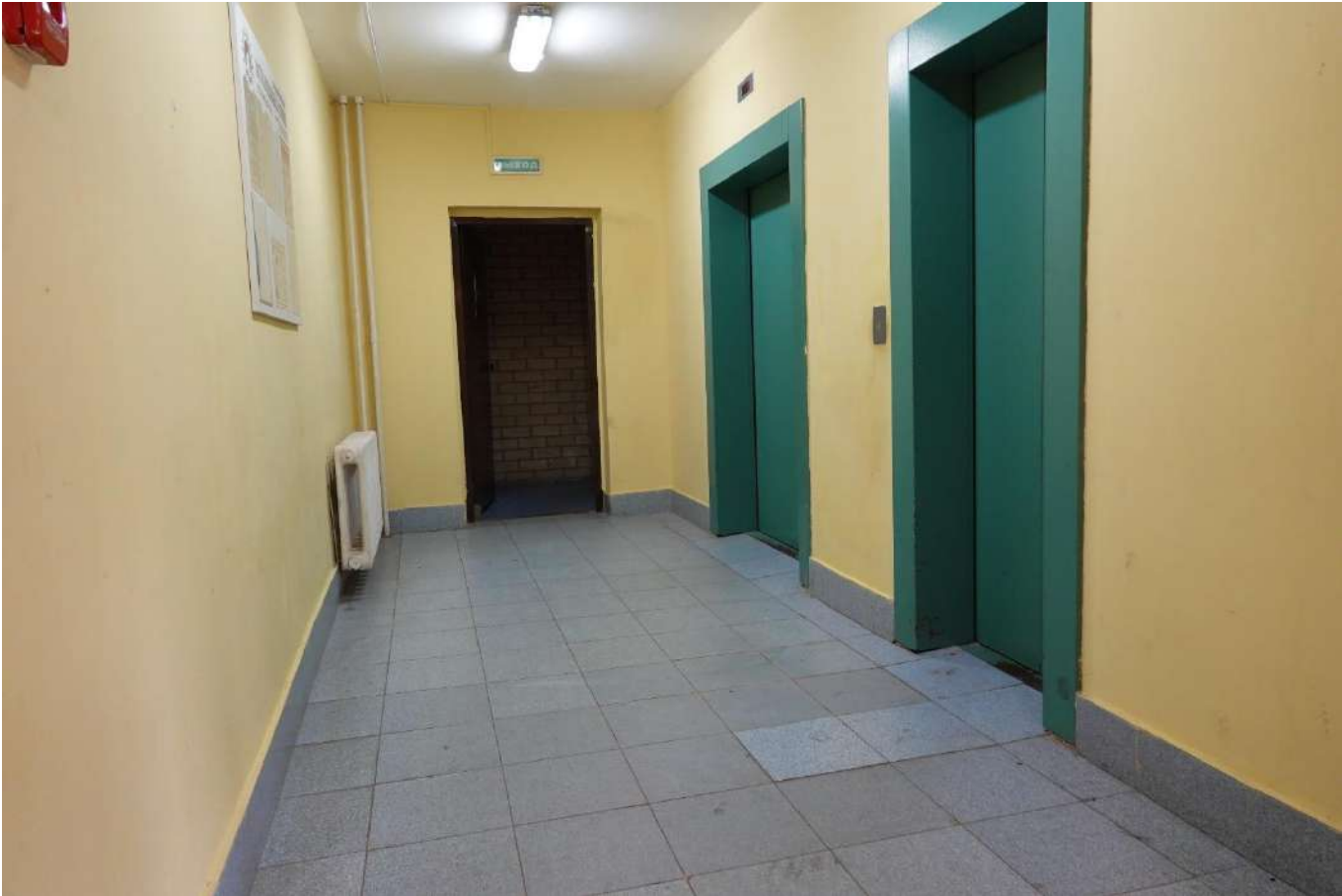
Фото 20. Общий вид лифтового холла МОП подъезда №1
