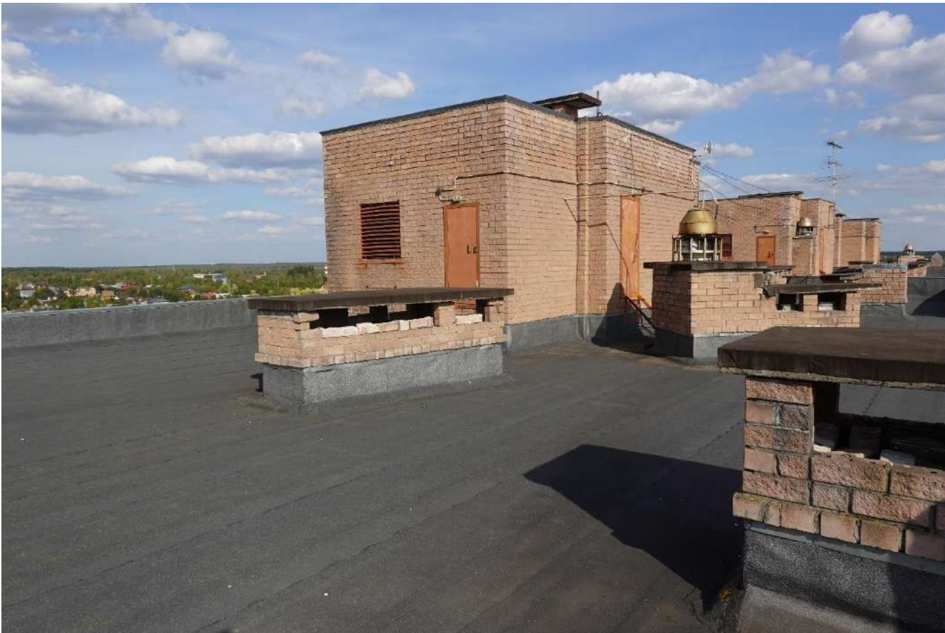
Фото 39. Общий вид надстройки выхода на кровлю
