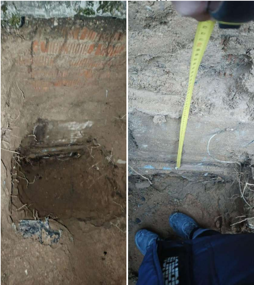
Фото 48. Общий вид шурфа 1. Замеры конструкций фундамента в шурфе 1
