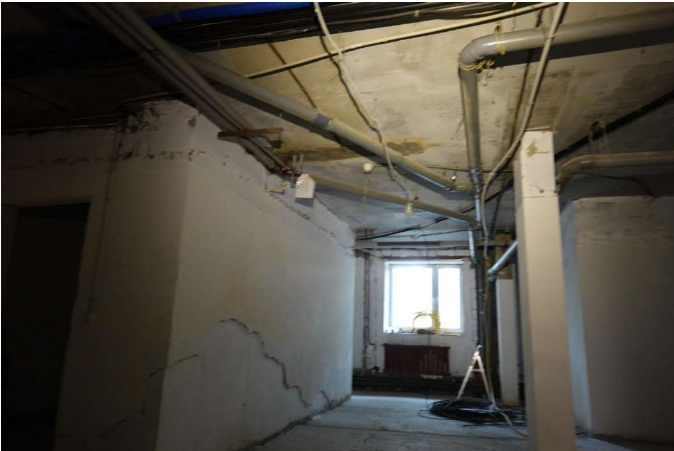
Фото 14. Помещение подвала в габаритах подъезда №2
