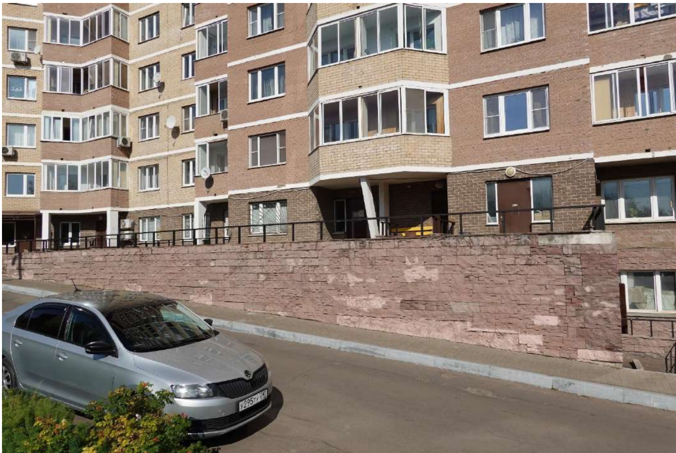
Фото 8. Общий вид пристройки подъезда №2
