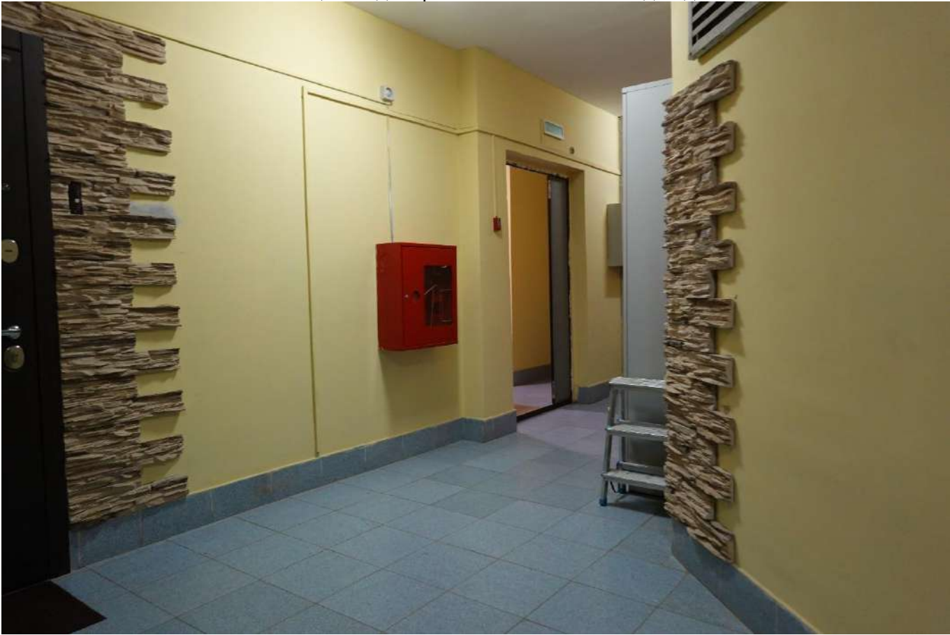
Фото 21. Общий вид приквартирного холла МОП подъезда №1
